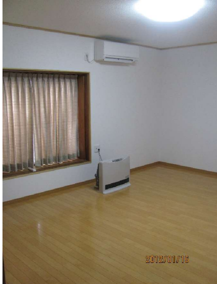
居室 床張り替え 温水ヒーター設置
